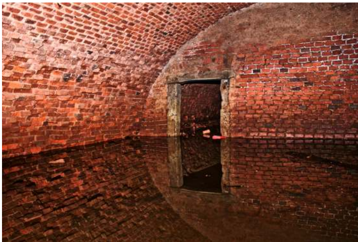
Obr. 44: Žihle zámek - sklepení s cihlovou klenbou (foto: Stráník)
