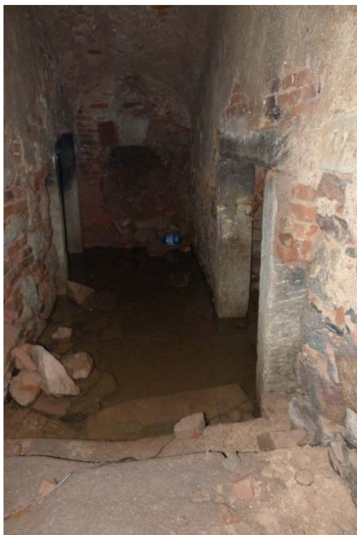
Obr. 40: Žihle zámek - vstupní chodba do sklepení v bočních vchody (foto: Stráník)
