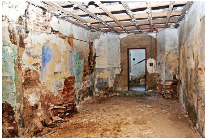
Obr. 59: Žihle zámek - místnost s valenou křížovou klenbou a se zbytky po laťování stropu navazuje na průjezd, foceno od jihozápadu (foto: Stráník)
