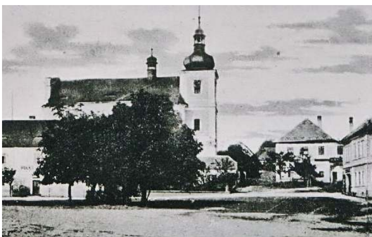
Obr. 10: Žihle okolo 1945 - zámek má eternitovou střechu a došlo k rozšíření vstupního portálu
