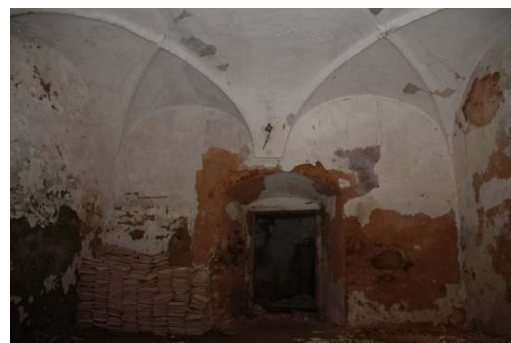
Obr. 73: Žihle zámek - jihozápadní místnost s neckovou klenbou s koutovými styčnými lunetami s přetínajícími se hřebínky, foceno od západu (foto: Stráník)
