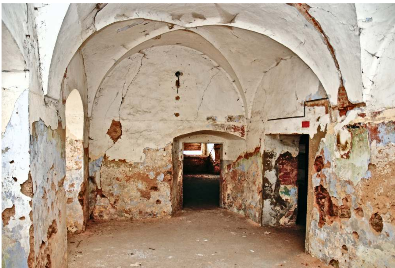
Obr. 63: Žihle zámek - severovýchodní místnost s valenou renesanční klenbou s hřebínky, foceno od severovýchodu (foto: Stráník)
