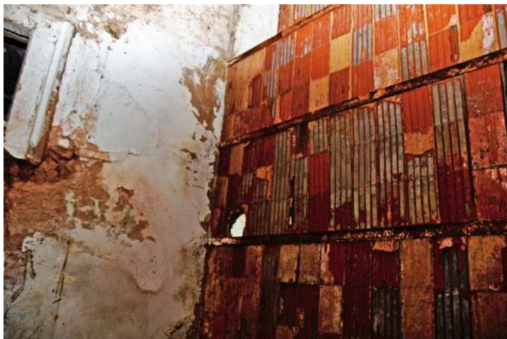
Obr. 54: Žihle zámek - Detail novodobého stropu v průjezdu zámku v přízemí (foto: Stráník)
