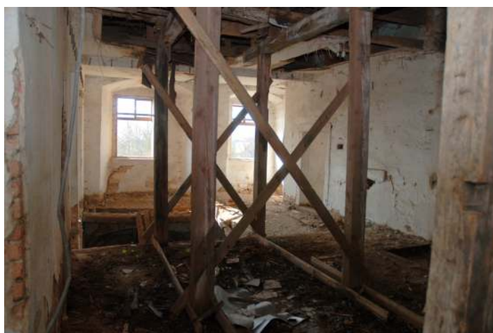
Obr. 84: Žihle zámek - Místnost nad průjezdem (foto: Stráník)
