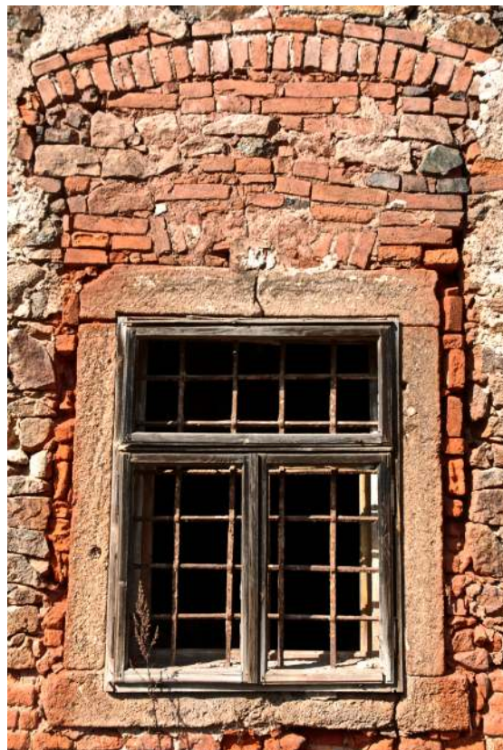
Obr. 33: Detail okna na východní straně v přízemí zámku v roce 2014 (foto: Stráník)
