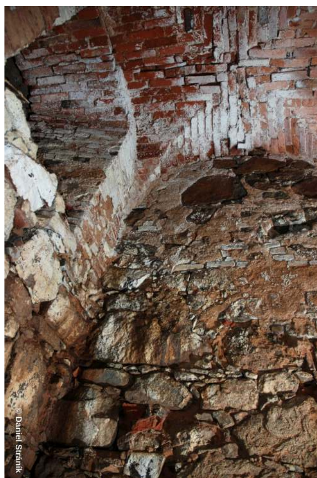
Obr. 37: Žihle zámek - podesta ve sklepení se zalděným oknem a cihlovou klenbou (foto: Stráník)
