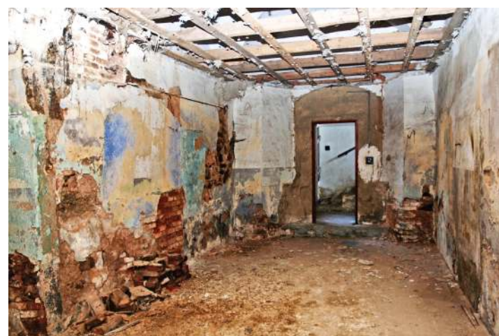
Obr. 72: Žihle zámek - jihovýchodní velká místnost s trémovým záklopkovým stropem, foceno od východu (foto: Stráník)
