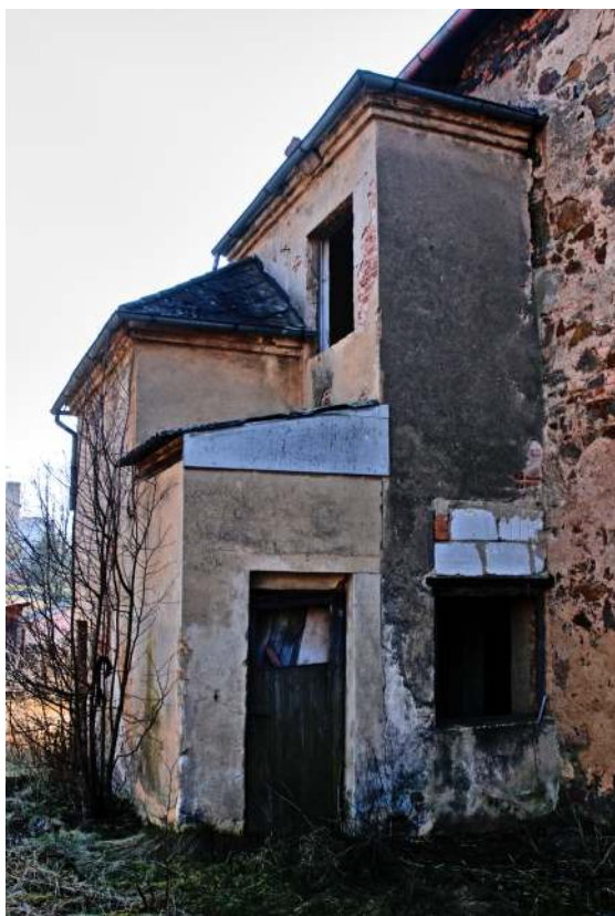
Obr. 32: Žihle - přístavek zámku v roce 2014 (foto: Stráník)
