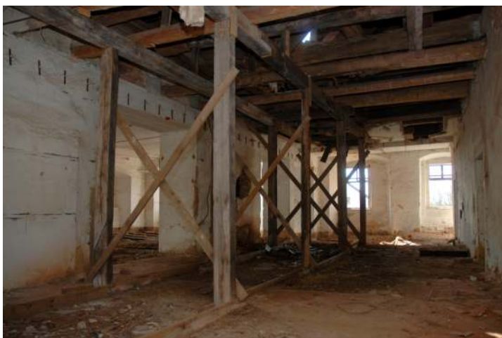
Obr. 83: Žihle zámek - Místnost nad průjezdem (foto: Stráník)
