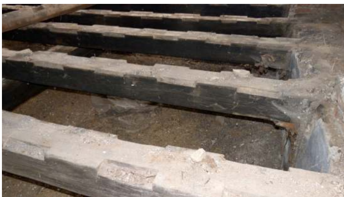
Obr. 80: Žihle zámek - průjezd zámku v přízemí foceno od severu (foto: Stráník)
