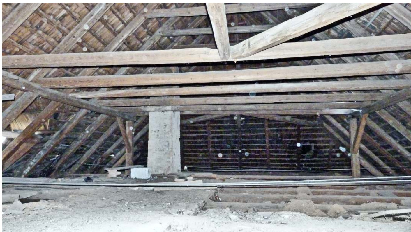
Obr. 116: Žihle zámek - krov zámku (foto: Stráník)
