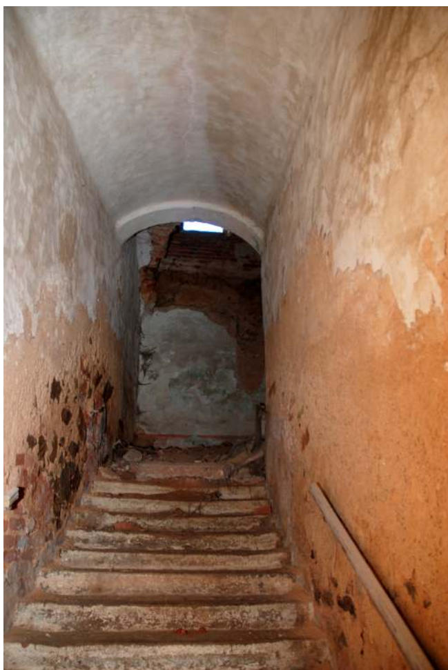
Obr. 111: Žihle zámek - schodiště do prvního patra (foto: Stráník)
