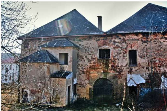
Obr. 30: Žihle - stav zámku v roce 2014 (foto: Stráník)
