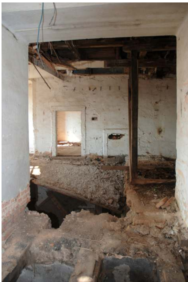
Obr. 95: Žihle zámek - Místnost nad průjezdem (foto: Stráník)
