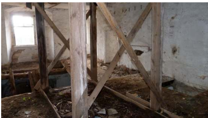
Obr. 89: Žihle zámek - Místnost nad průjezdem (foto: Stráník)
