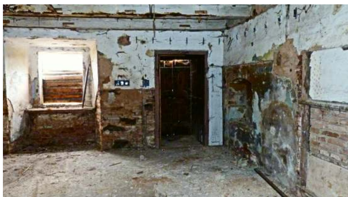
Obr. 69: Žihle zámek - jihovýchodní velká místnost s trémovým záklopkovým stropem, foceno od severovýchodu (foto: Stráník)
