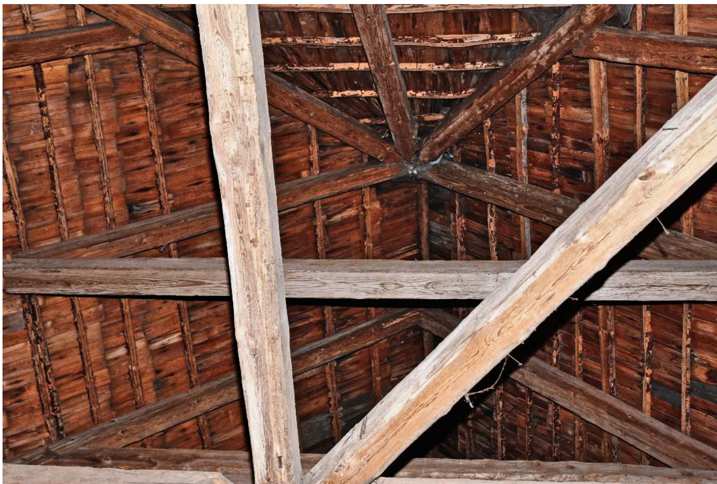
Obr. 116: Žihle zámek - krov zámku (foto: Stráník)
