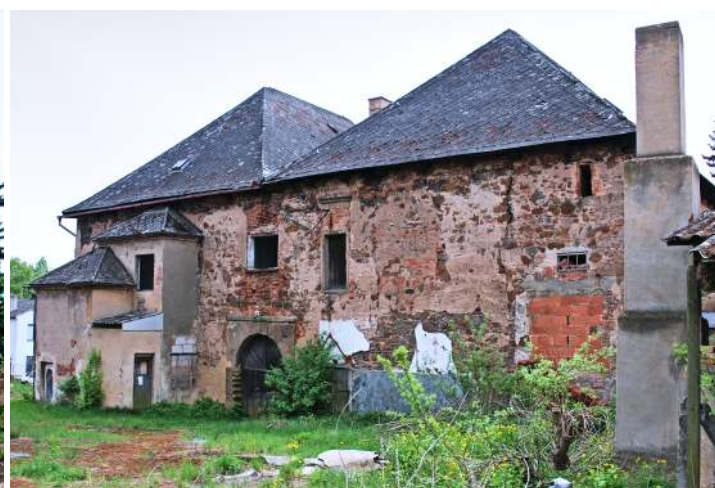
Obr. 21: Žihle - stav zámku v roce 2009 (foto: Stráník)
