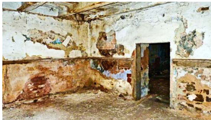
Obr. 68: Žihle zámek - jihovýchodní velká místnost s trémovým záklopkovým stropem, foceno od jihovýchodu (foto: Stráník)
