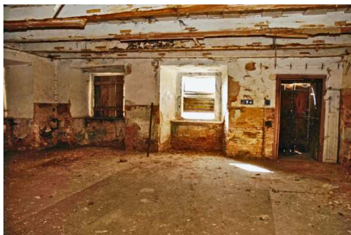
Obr. 71: Žihle zámek - jihovýchodní velká místnost s trémovým záklopkovým stropem, foceno od severovýchodu (foto: Stráník)
