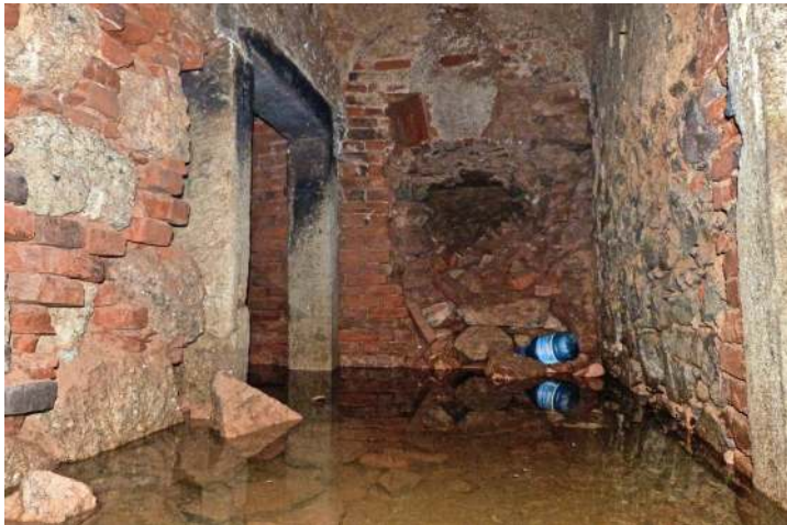
Obr. 42: Žihle zámek - vstupní chodba do sklepení v bočních vchody (foto: Stráník)
