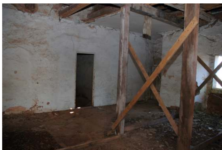
Obr. 85: Žihle zámek - Místnost nad průjezdem (foto: Stráník)
