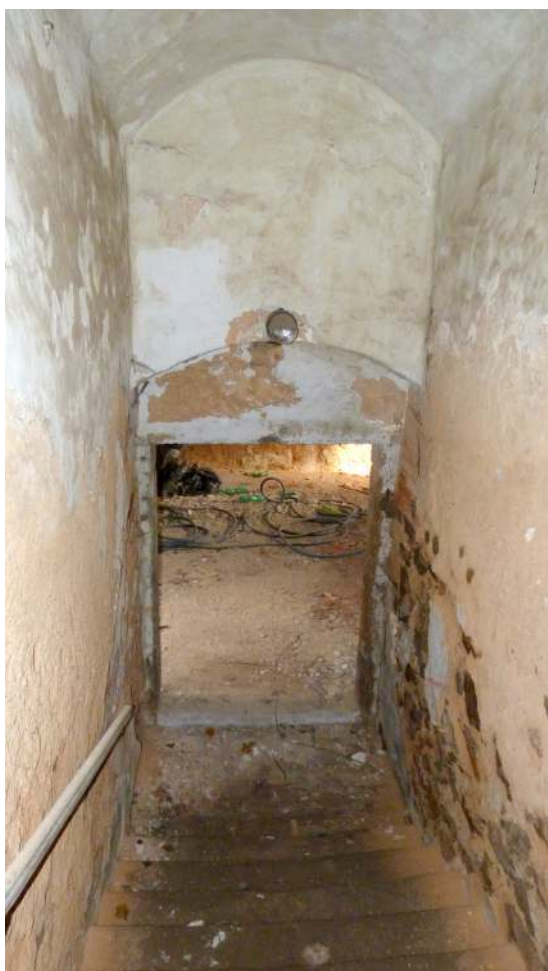
Obr. 103: Žihle zámek - schodiště do prvního patra (foto: Stráník)
