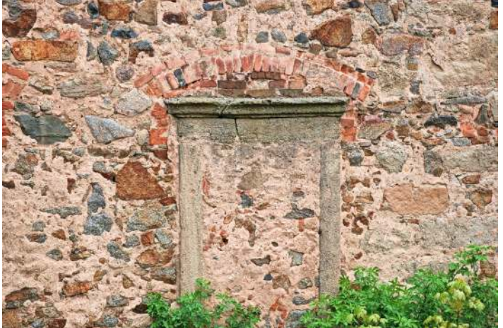
Obr. 27: Žihle - stav zámku v roce 2009 (foto: Stráník)
