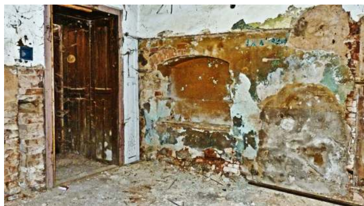
Obr. 70: Žihle zámek - jihovýchodní velká místnost s trémovým záklopkovým stropem, foceno od východu (foto: Stráník)
