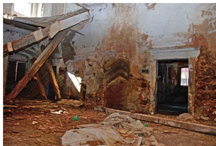
Obr. 50: Žihle zámek - průjezd zámku v přízemí foceno od severovýchodu (foto: Stráník)
