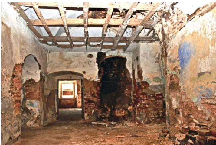
Obr. 58: Žihle zámek - místnost s valenou křížovou klenbou a se zbytky po laťování stropu navazuje na průjezd, foceno od severovýchodu (foto: Stráník)
