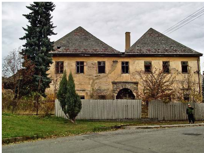
Obr. 16: Žihle - stav zámku v roce 2004 (archiv MT)
