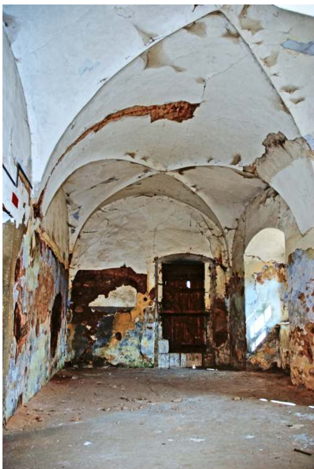
Obr. 61: Žihle zámek - severovýchodní místnost s valenou renesanční klenbou s hřebínky, foceno od jihozápadu (foto: Stráník)
