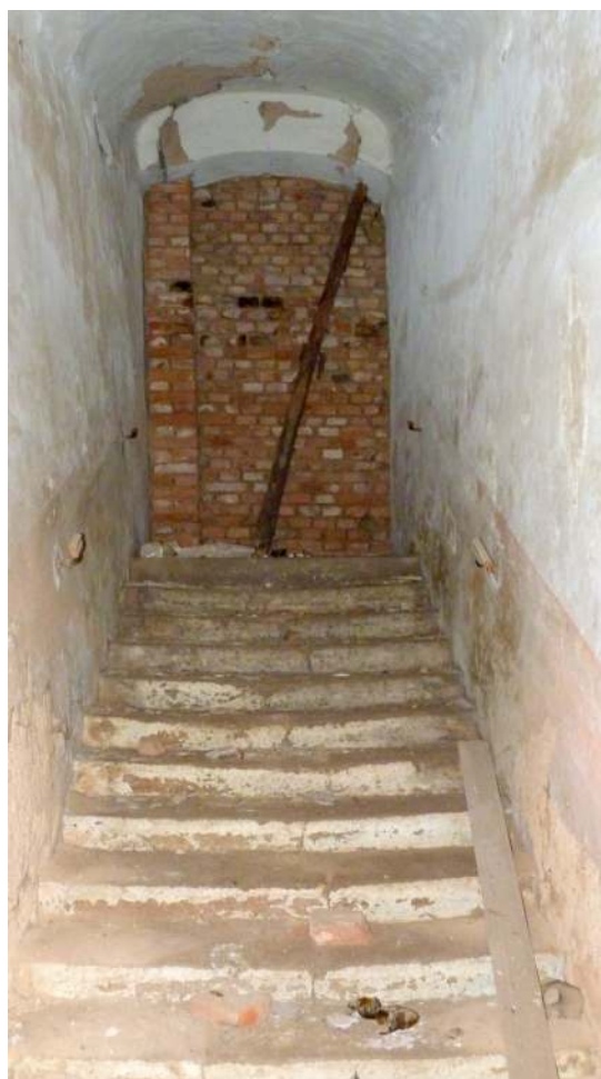
Obr. 104: Žihle zámek - zazděné schodiště (foto: Stráník)
