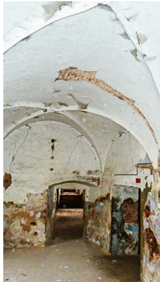
Obr. 65: Žihle zámek - severovýchodní místnost s valenou renesanční klenbou s hřebínky, foceno od severovýchodu (foto: Stráník)
