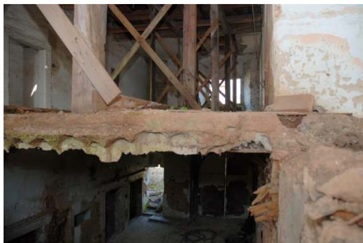
Obr. 91: Žihle zámek - Místnost nad průjezdem (foto: Stráník)
