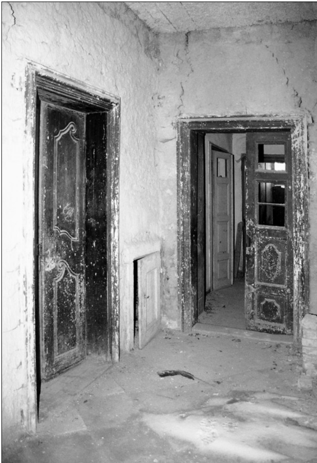
Obr. 18: Zámek Pravonín, interiér západního ramene chodby v patře s příkladacím portálkem.
