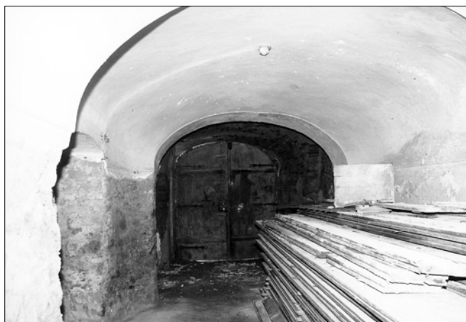
Obr. 16: Zámek Pravonín, průhled chodbou ve východní části zámku.
