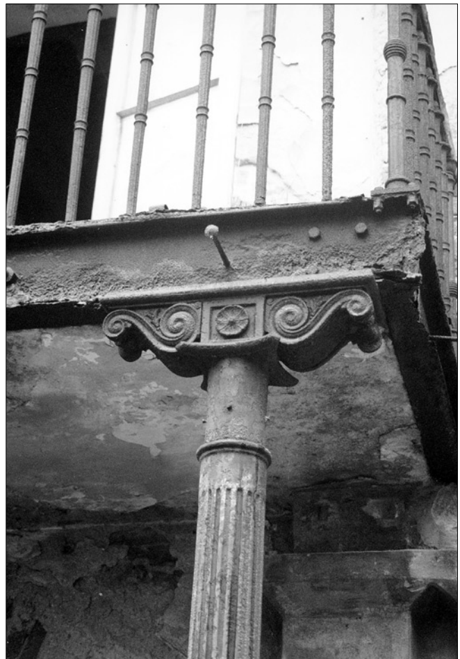
Obr. 21: Zámek Právoňín, detail hlavice litinového sloupku balkónu nad vstupním portálem.
