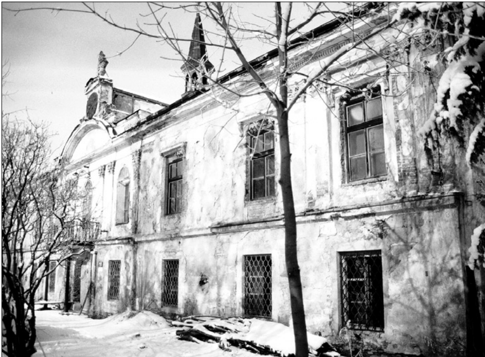
Obr. 3: Zámek Pravonín, celkový pohled od jihovýchodu.
