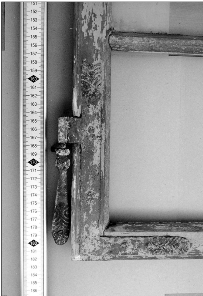
Obr. 20: Zámek Právoňín, detaily závěsů a rohového kování barokního okna, druhotně použitého v mladší přičce v interiéru přízemí zámku.
