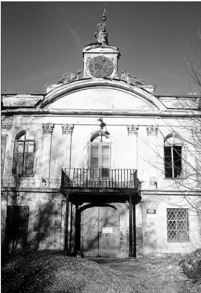
Obr. 4: Zámek Pravonín, celkový pohled střední část hlavního (jižního) průčelí se štítem.
