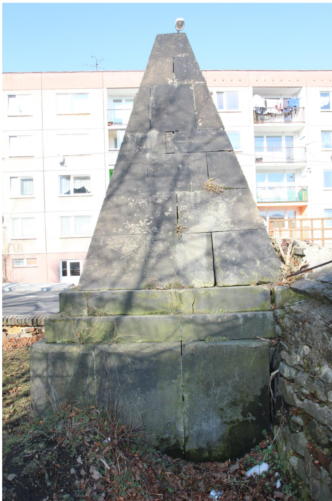
Boční pohled na náhrobek s výrazným statickým poškozením
