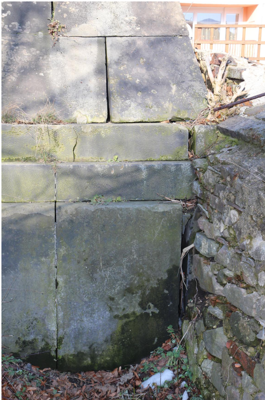
Detail vychýlení ohradní zdi
