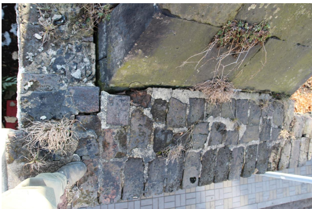
Detail odklonu kamenné zdi
